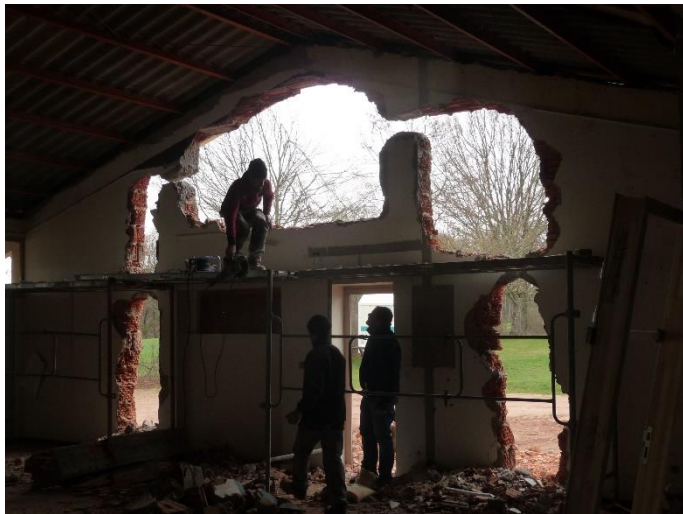
Ci-dessus le percement d'une large ouverture sur la façade sud et mise en place d'une verrière ouvrante
